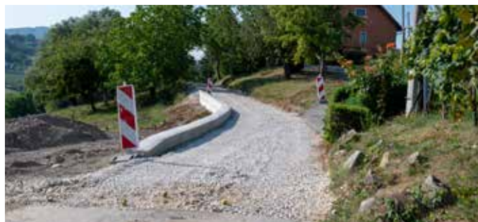
Sanacija klizišta u Vrbišnici
